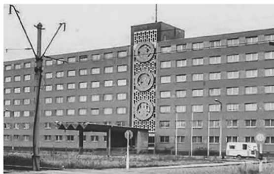
In der Stasi-Bezirksverwaltung am Gimritzer Damm in Halle arbeiteten bis zum Mauerfall rund 3.000 hauptamtliche Mitarbeiter.
