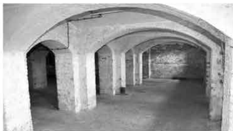
Blick in einen großen Raum im Keller des Zellentrakts
