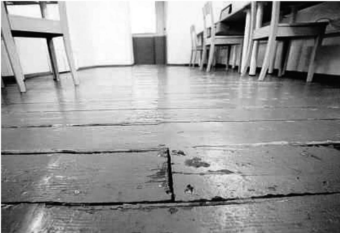
**Im Medienraum (Foto) und vor der historischen Gaskammer sind die Holzdielen teilweise angefault und sehr dünn. Weil sich die Sanierung verzögerte, drohte aus Sicherheitsgründen eine Sperrung beider Räume.** FOTO: ENGELBERT PÜLICHER
