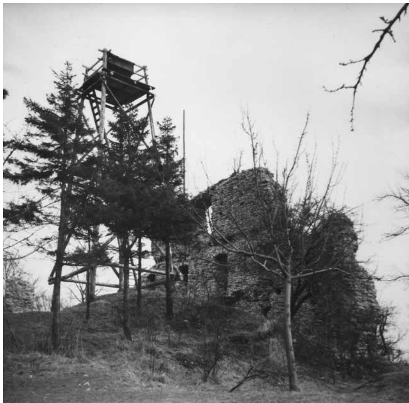
Holzwachturm neben der Ruine der Stapelburg, 1956.
