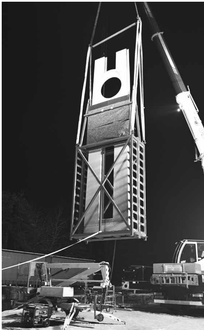
Die in ein Hubgestell eingespannte Stele wird mittels eines Krans aus dem Mittelstreifen gehoben (2025).
