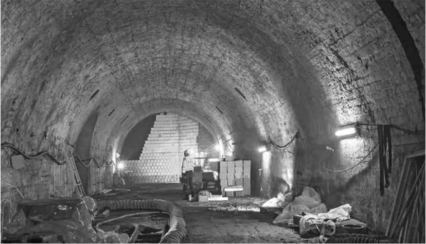
Stollenabschnitt der ehemaligen Unterlageanlage „Klosterwerke“, der nicht verfüllt werden soll, April 2021. Im Hintergrund Maurerarbeiten in Vorbereitung der Verfüllung. Der erhalten gebliebene nicht verfüllte Abschnitt hat eine Länge von 50 Meter.
